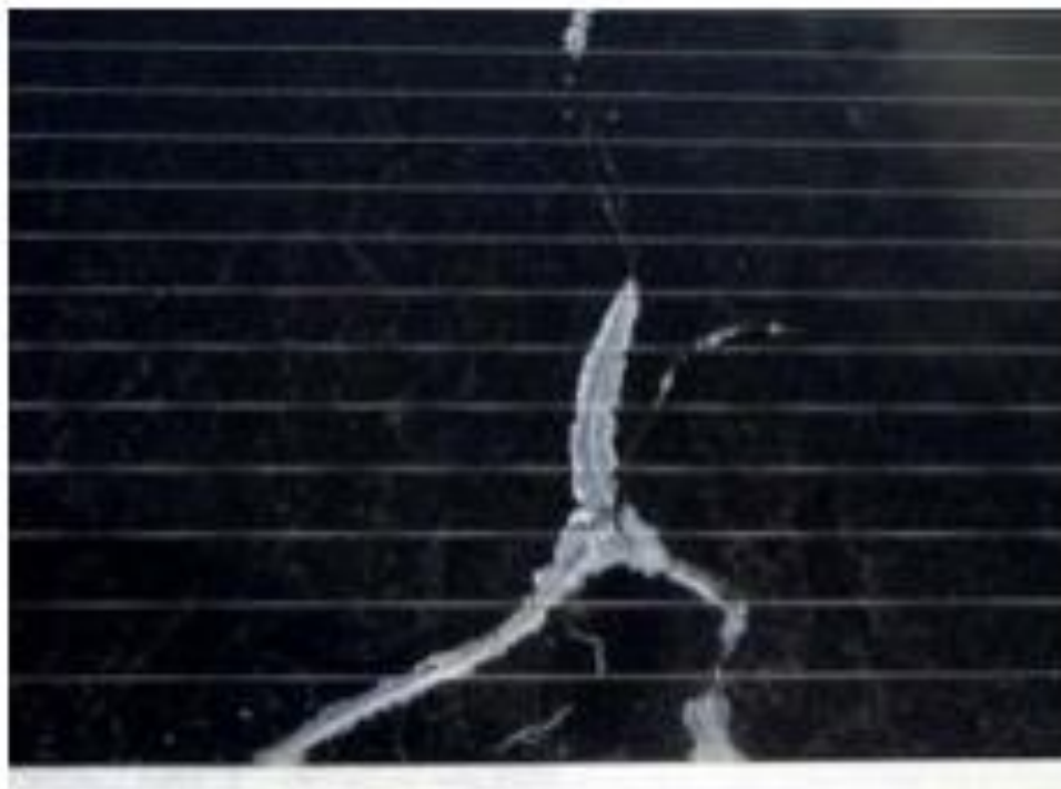
Figura 7.3. Vidrio severamente agrietado 1
