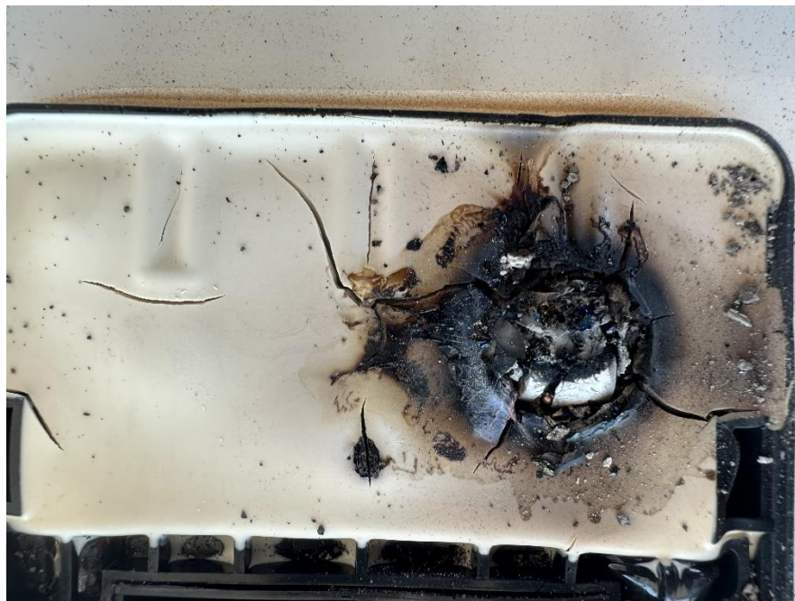
Figura 7.34. Junction box con una conexión interna y diodo de derivación quemados y destruidos.
