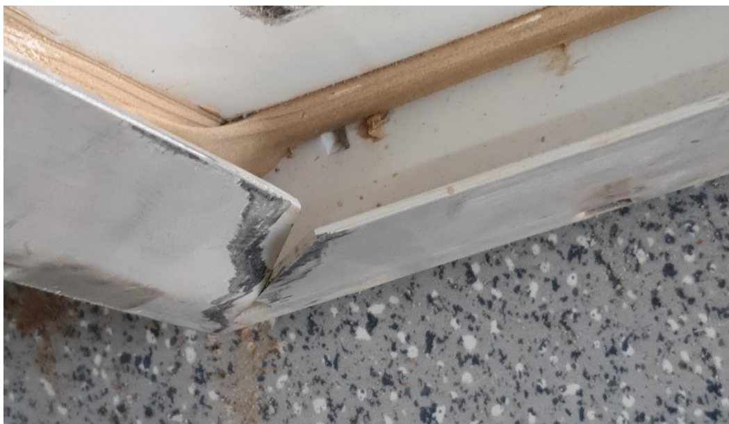
Figura 7.36. Marco con juntas separadas
