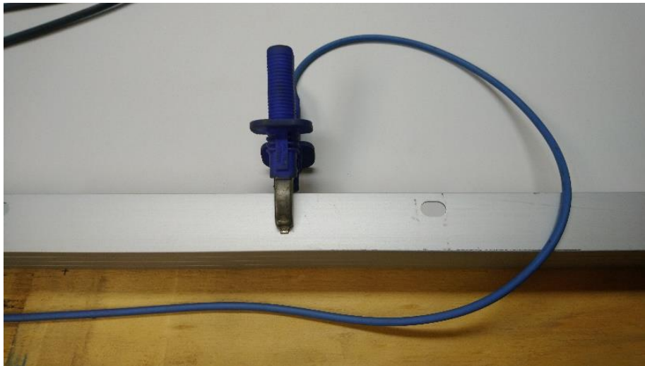
Figura 3.6. Pinza del megaóhmetro conectada a una sección limpia del marco.
