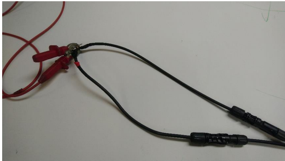
Figura 3.4. Terminales del módulo, con adaptadores, cortocircuitados y conectados a la pinza del megaóhmmetro.
