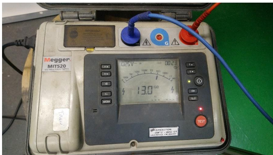
Figura 3.9. Megaóhmometro en operación.
