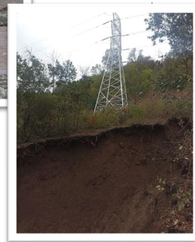
LT 154 kV Tinguiririca – San Fernando, una estructura colapsó debido al temporal y la crecida del río Tinguiririca en el invierno del año 2023.
