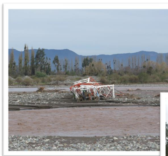
LT 154 kV Tinguiririca – San Fernando, una estructura colapsó debido al temporal y la crecida del río Tinguiririca en el invierno del año 2023.
