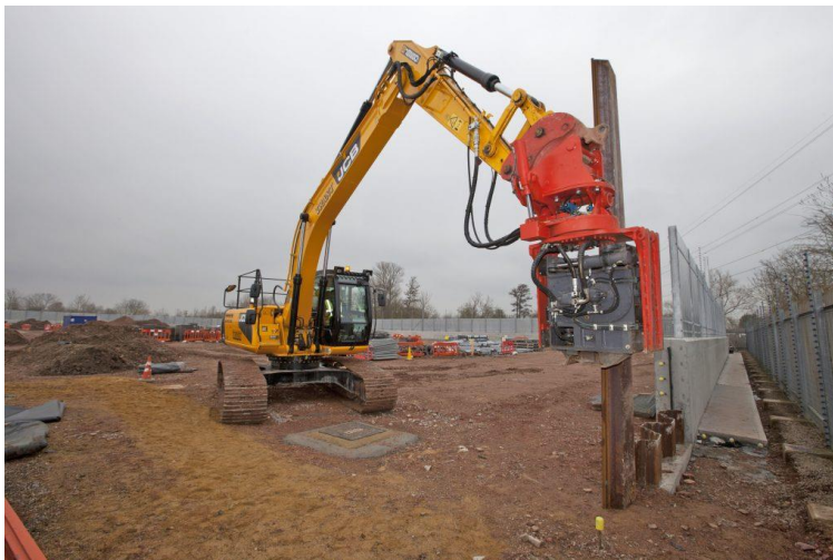
Figura 3.1: Construcción de barreras de protección de subestaciones.
