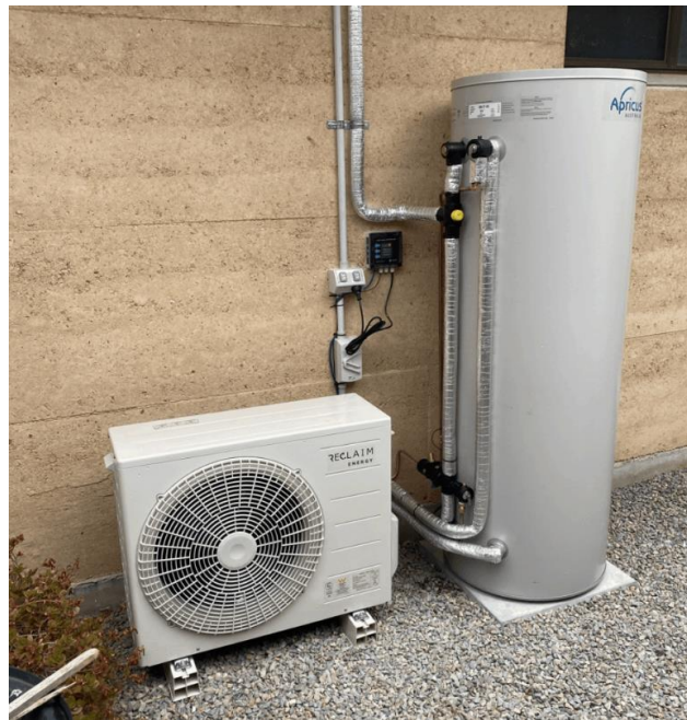
Figura 4.15: Ejemplo de artefactos eléctricos afectados a regulación
