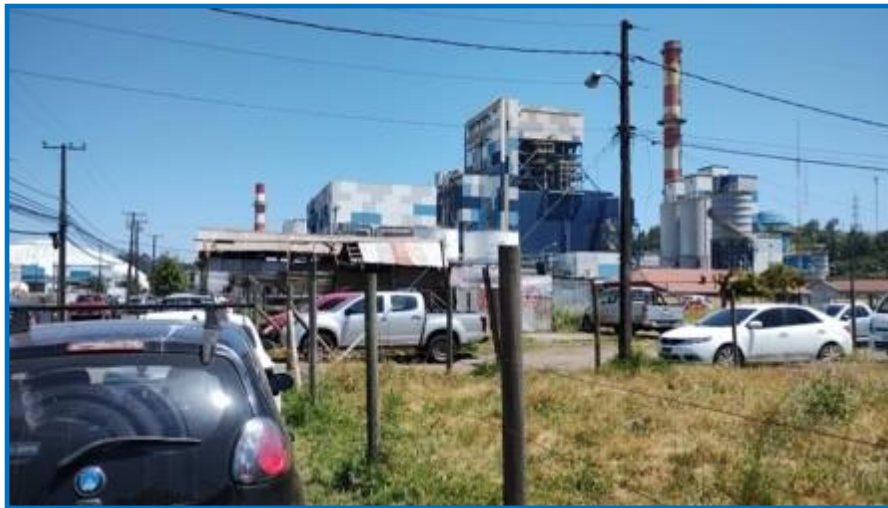
Vista sector de estacionamientos aldaño a Bocamina II – Imagen Propia.
