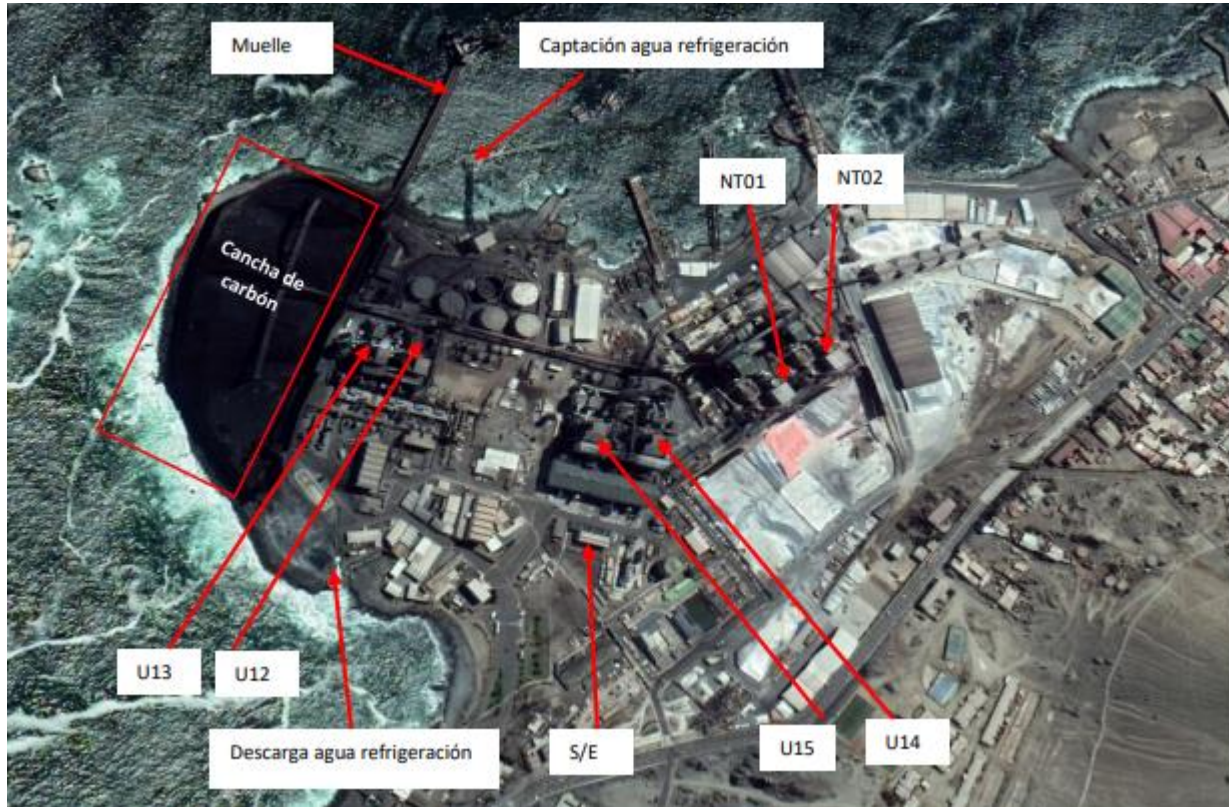
Figura 9: Caracterización del complejo termoelectrico Tocopilla – Nueva Tocopilla. Fuente: (inodú, 2018)
