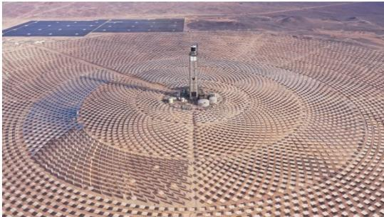
Figura 12. Planta de concentración solar de potencia ubicada en María Elena en el centro de atacama [24].
