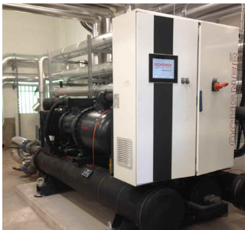
Figura 59. Bomba de calor geotérmica de 420 kW térmicos que opera en el sistema de refrigeración, calefacción y producción de ACS en la Universidad de Borgoña, Francia. Fuente: [52].
