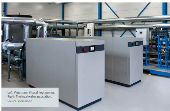
Figura 54. Bombas de calor geotérmicas implementadas en el sistema de calefacción distrital de Bergheim, Alemania. Fuente: [52].
