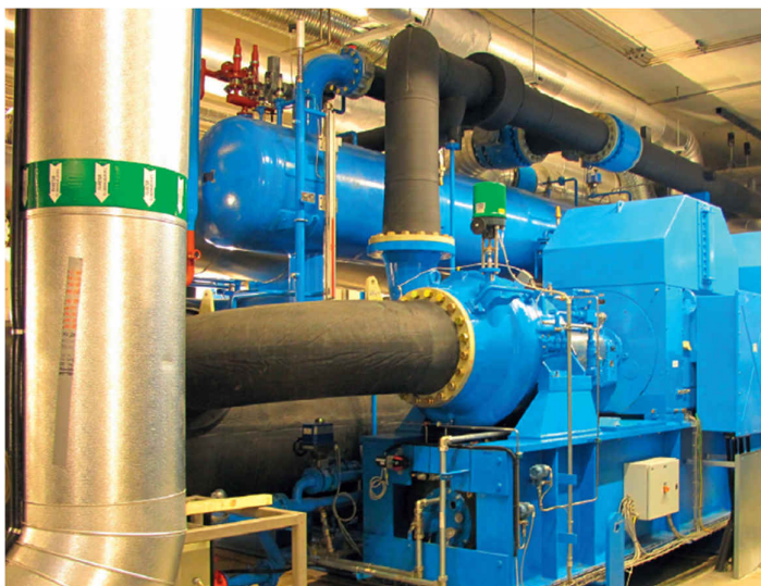
Figura 57. Bomba de calor geotérmica que produce agua caliente a 75°C para el sistema de calefacción distrital de Fornebu, Noruega. Fuente: [52].
