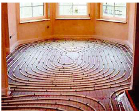
Figura 30. Suelo radiante (izquierda) y radiadores (derecha). Fuente: [38].
