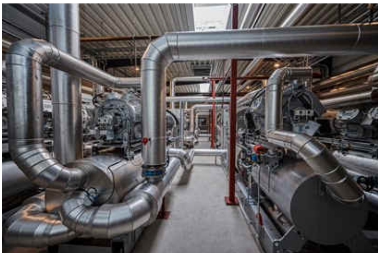
Figura 29. Bombas de calor de uso industrial para generación de calor. Fuente: [37].
