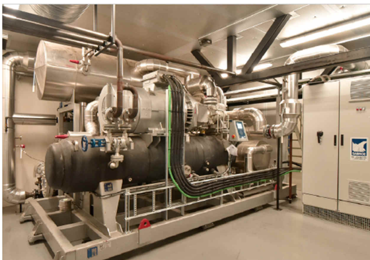
Figura 56. Bomba de calor aerotérmica de 1,3 MW térmicos que opera en el sistema de calefacción distrital de Jutlandia Occidental, Dinamarca. Fuente: [52].
