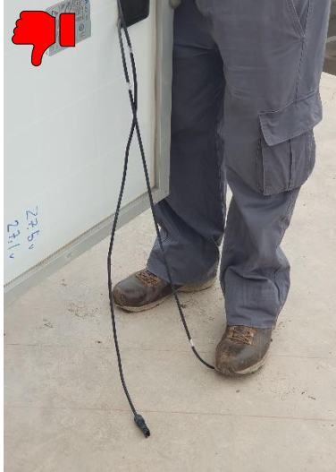
Fig. 7.7. Conectores siendo pisados durante su manipulación para el montaje 27
