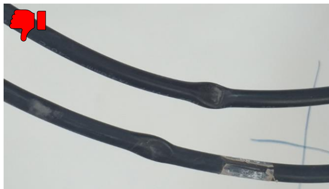
Fig. 7.3: Cable MFV con daño visible por apriete 22 .
