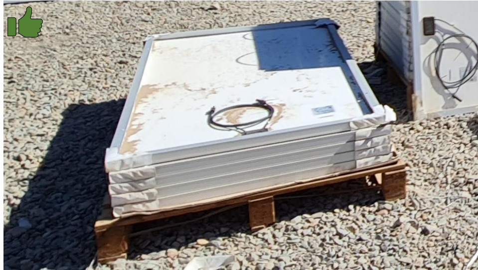
Fig. 6.13: MFV comenzando a ser apilados utilizando esquineros de cartón.
