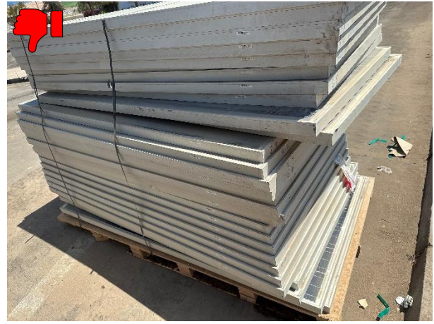
Fig. 6.18: Pila de MFV con zunchos sueltos.
