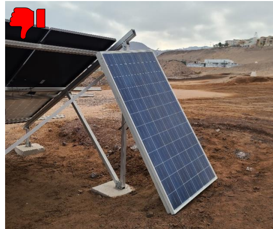
Fig. 6.2: MFV apoyados de manera inestable.
