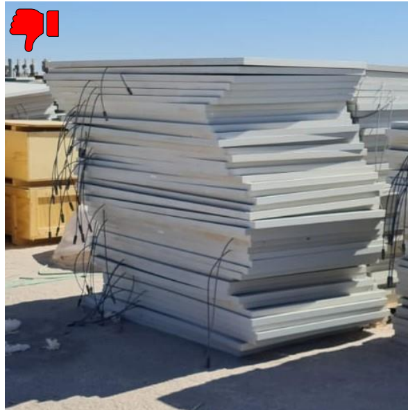
Fig. 6.10: MFV apilados en cantidades excesivas y de mala manera.
