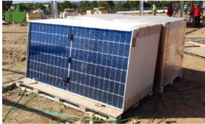
Fig. 6.9: MFV almacenados en vertical en terreno para su posterior instalación 21 .
