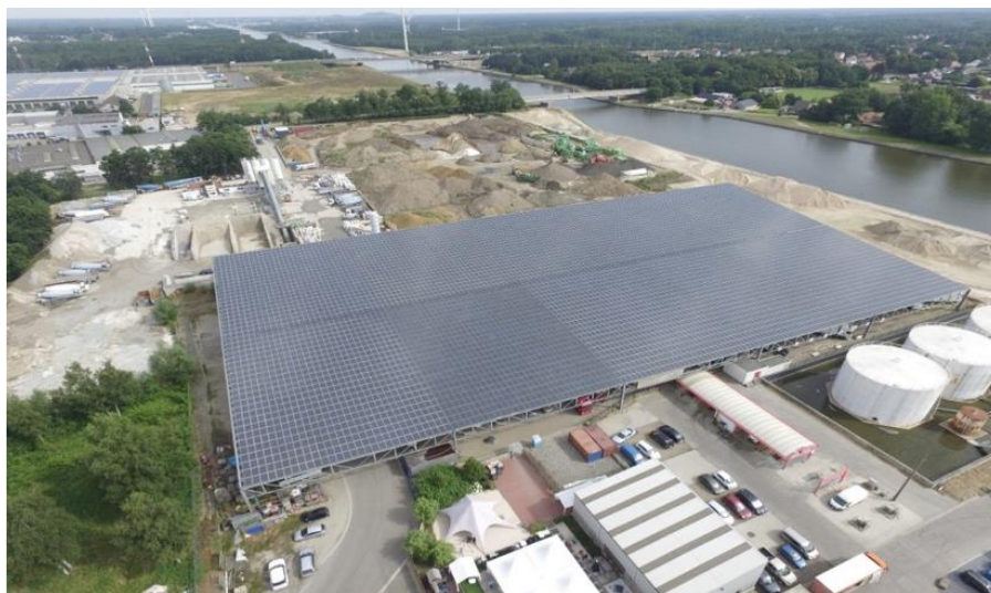
Fig. 10.9: Vista aérea planta FV Cloverleaf.
