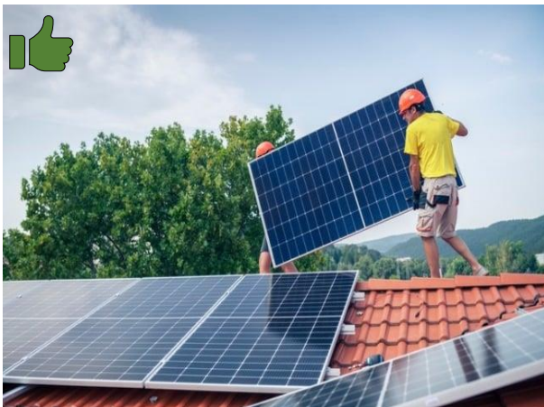
Fig. 6.3: Instaladores transportando un MFV entre dos personas. 19
