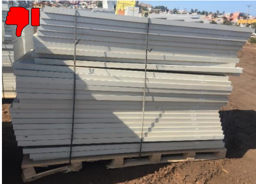
Fig. 6.15: Forma incorrecta de paletizar MFVs.
