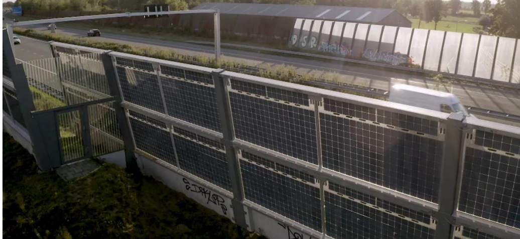
Fig. 10.3: Barrera acústica de 400 metros en autopista de Holanda 37 .
