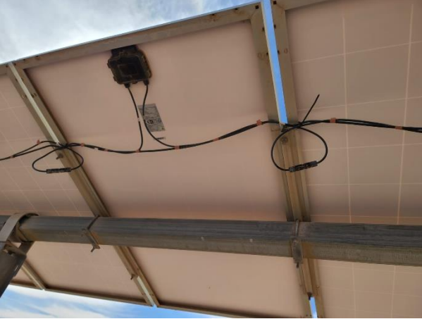
Fig. IV.3 Cables sujetos al marco de los MFV mediante amarras plásticas
