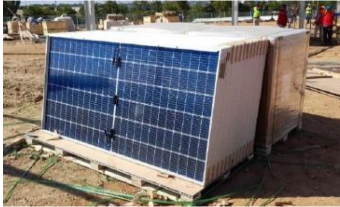
Fig. III.5 MFV almacenados en vertical en terreno para su posterior instalación 10
