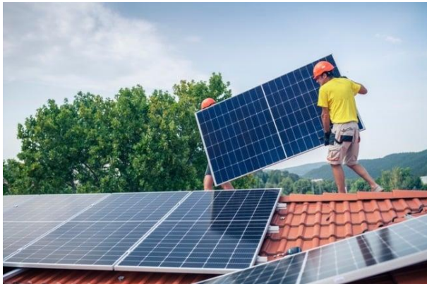
Fig. III.3. Instaladores transportando un MFV entre dos personas. 8
