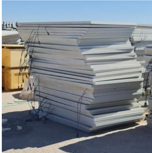
Fig. III.6. MFV apilados en cantidades excesivas y de mala manera
