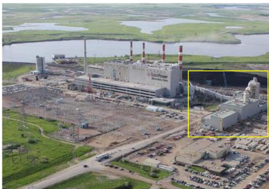
Figura 5.2.4. Foto de la Central Boundary Dam de SaskPower, donde se ve a la derecha (recuadro amarillo) la planta Cansolv de captura de SO<sub>2</sub> y CO<sub>2</sub> [90].
