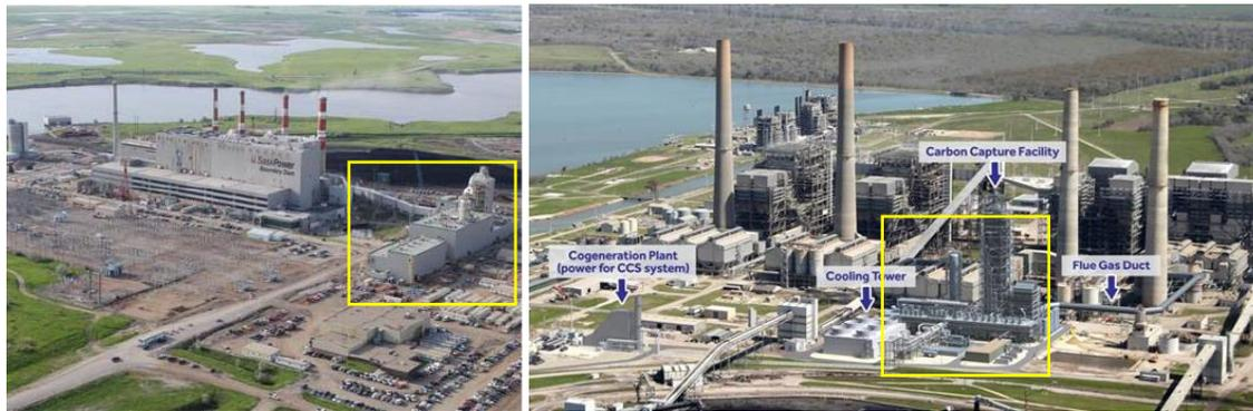
**Figura 42: Centrales Boundary Dam y WA Parish con sus plantas de captura de CO<sub>2</sub> en recuadros amarillos.**
