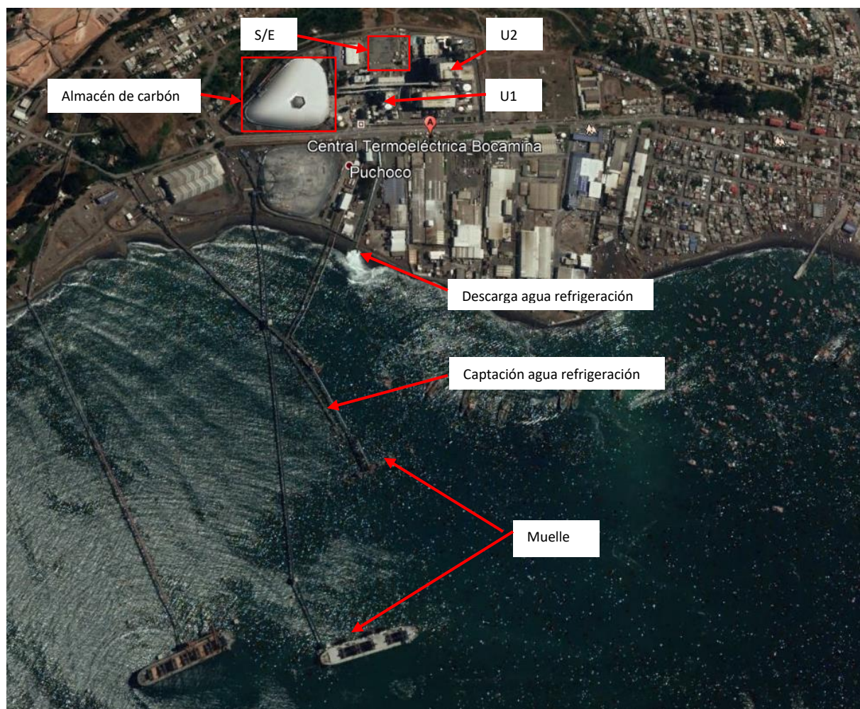
Figura 19: Complejo termoeléctrico Bocamina.
