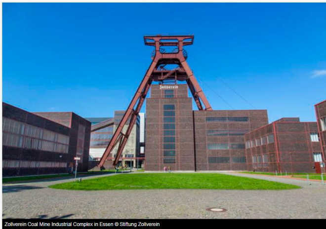
Zollverein Coal Mine Industrial Complex in Essen © Stiftung Zollverein
